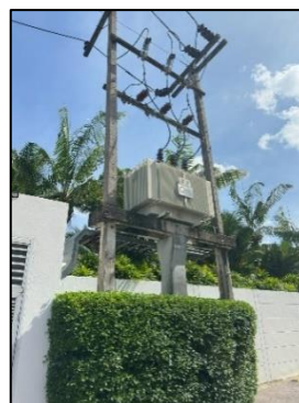
รูปที่ 3-24 หม้อแปลงไฟฟ้าโรงแรม
