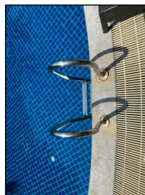
รูปที่ 3-41 แถบกันลื่นไว้บริเวณบันไดสำหรับขึ้นจากสระว่ายน้ำ
